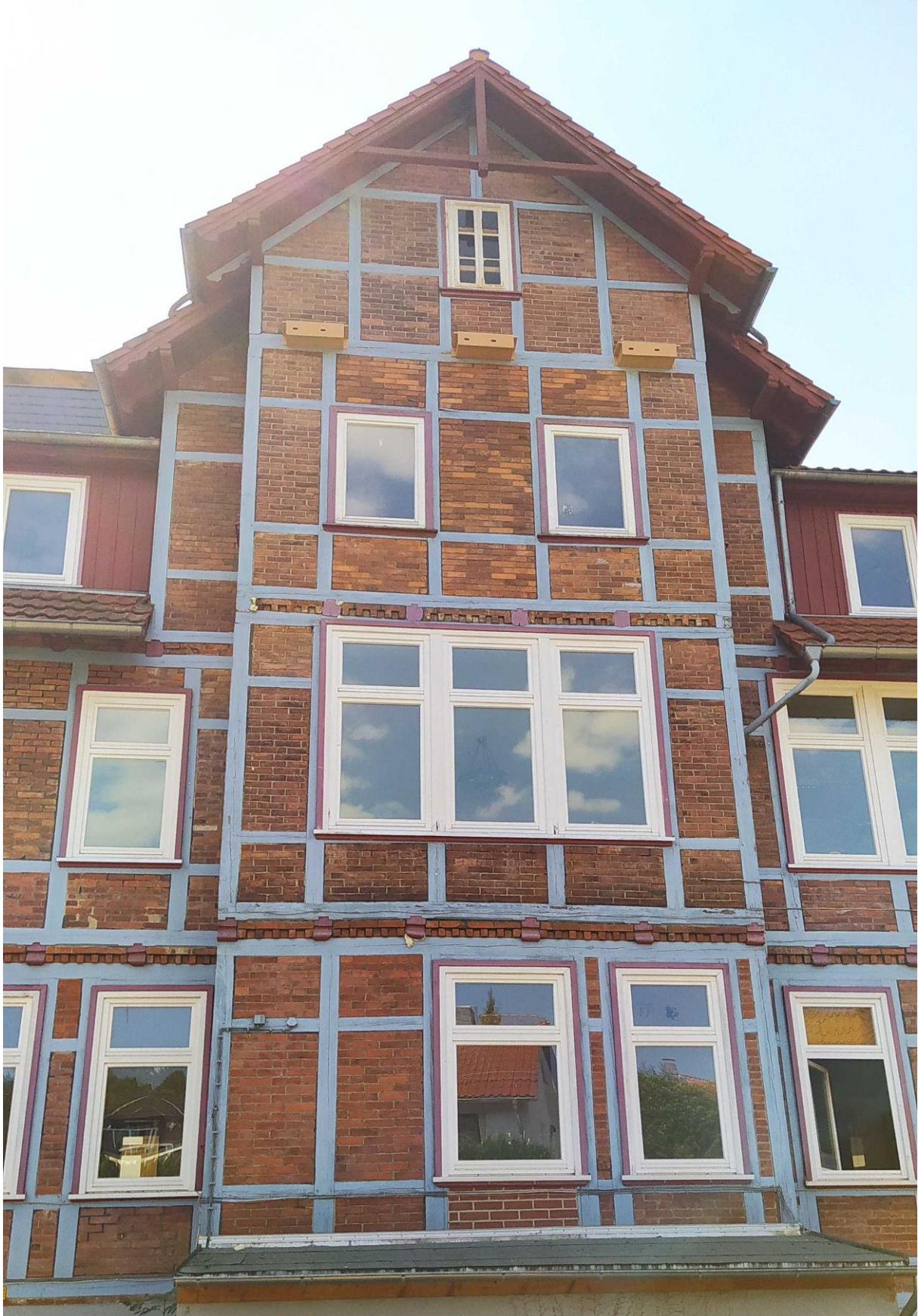
Mauerseglerkästen am Naturschutzzentrum angebracht
