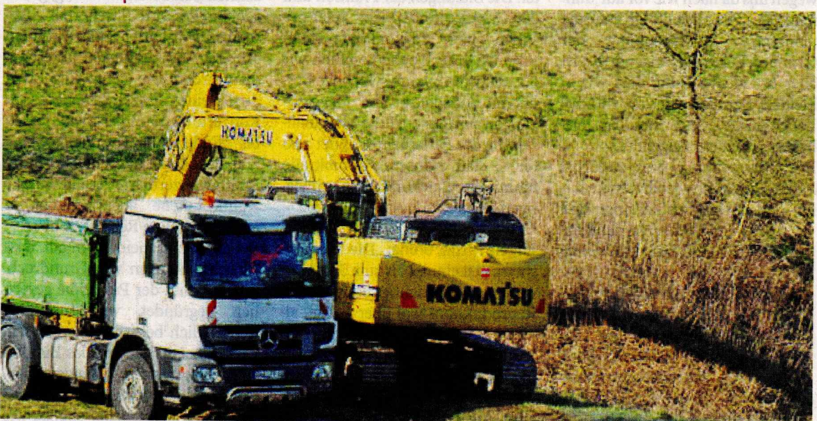
Letzte Arbeiten werden erledigt.
